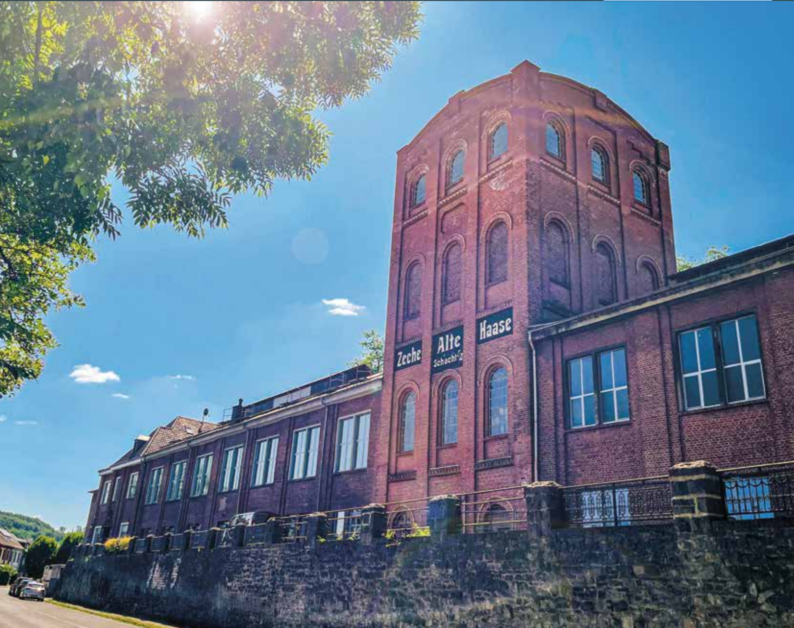
Der Malakow-Turm der Zeche Alte Haase auf Schacht I/II
