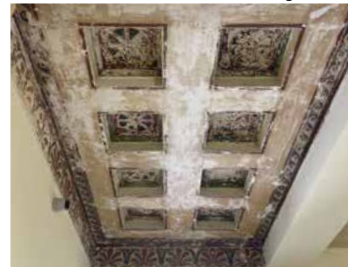
Bei den Sanierungsarbeiten wurden Deckenmalereien von 1926 freigelegt, welche nun als eine Art Schaufenster in die Vergangenheit zur Schau gestellt werden.
