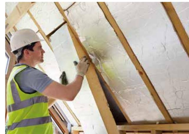
Handwerker bei einer Zwischensparrendämmung.
