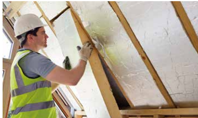
Handwerker bei einer Zwischensparrendämmung.
