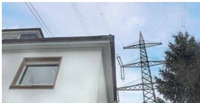
Es gibt in Deutschland kein Gesetz, das einen Mindestabstand von Hochspannungsleitungen zu Wohngebäuden vorschreibt. Seit dem Jahr 2013 gibt es ein Überspannungsverbot von Gebäuden und Gebäudeteilen, die zum dauerhaften Aufenthalt von Menschen bestimmt sind. Ausnahme sind unter anderem bestehende Freileitungstrassen wie hier an der Schmiedestraße in Sprockhövel.
