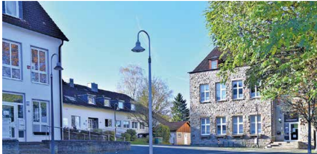
Die Kindertageseinrichtung KiFaz befindet sich aktuell im alten Bürgerhaus, Hauptstraße 6 (rechts im Bild). Davor war sie in der Hauptstraße 8 (hinteres Gebäude auf der linken Bildseite). Aus hygienischen Gründen musste die Einrichtung umziehen. Im Oktober 2022 wurde die Einrichtung im alten Gebäude geschlossen. Foto: Pielorz
