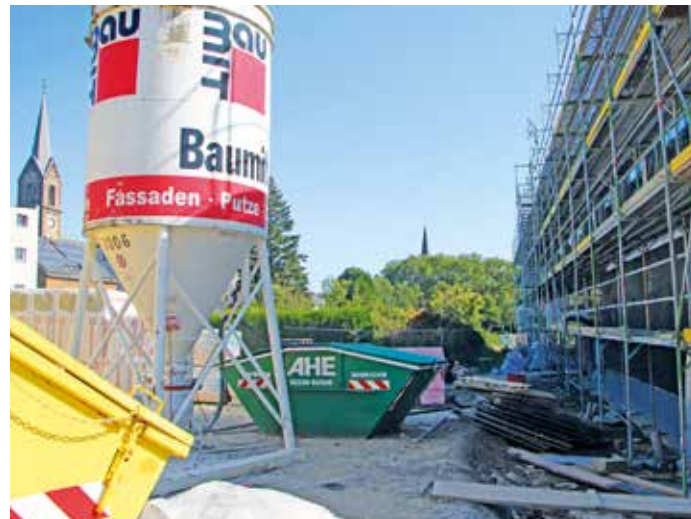
Baustelle des neuen, zweigeschossige Quartierszentrum, das auf einem 2,2 Hektar großen Gelände nordwestlich des Bahnhofs Annen Nord entsteht. Fotos: Niemerig/Kathagen
