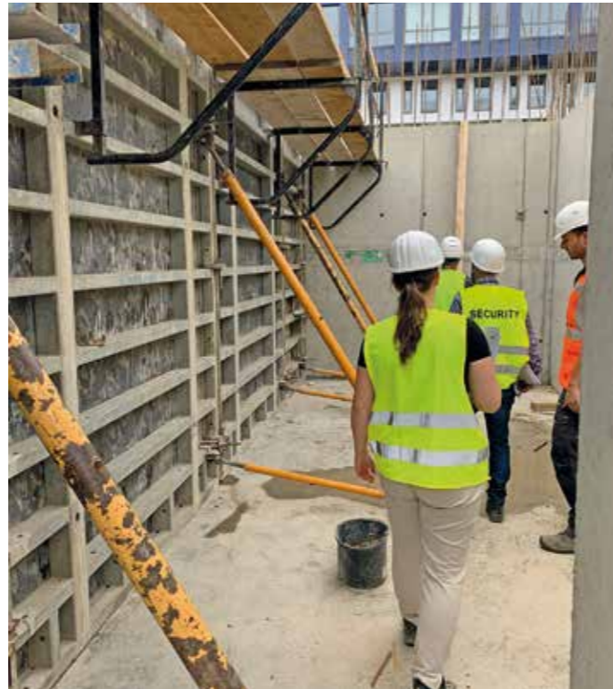
Hier entsteht ein Treppenhaus.
