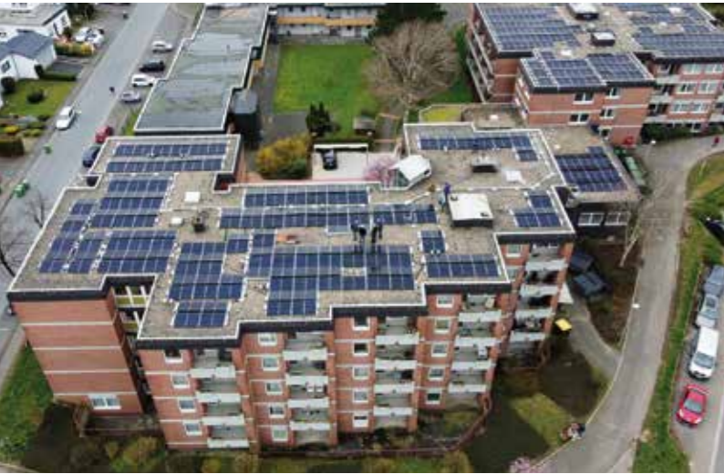
Grünen Strom aus eigenen Photovoltaik-Anlagen beziehen jetzt die drei AWO Seniorenzentren in Witten (Egge), Hemer und Kierspe. Foto: BEG-58
