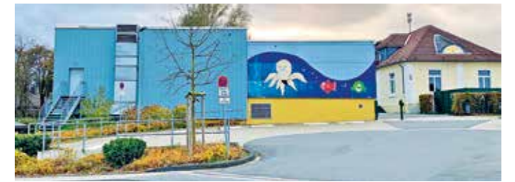
Das alte Schwimmbad macht Platz für einen Neubau. Foto: UvK/Ennepe-Ruhr-Kreis
