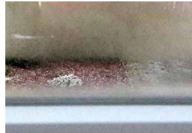
Kein Durchblick am Morgen: Von außen beschlagene Fenster sind kein Grund zur Sorge, sondern Zeichen für eine gute Wärmedämmung der Verglasung. Foto: Energie-Fachberater.de
