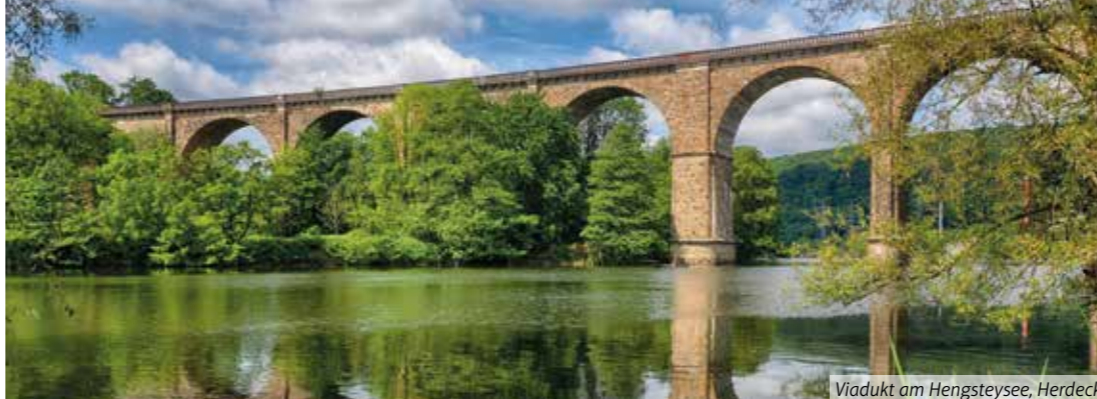
Viadukt am Hengsteysee, Herdecke
