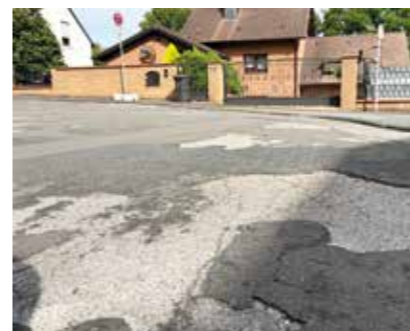
Unionstraße und Karl-Roth-Weg vor der Sanierung.
