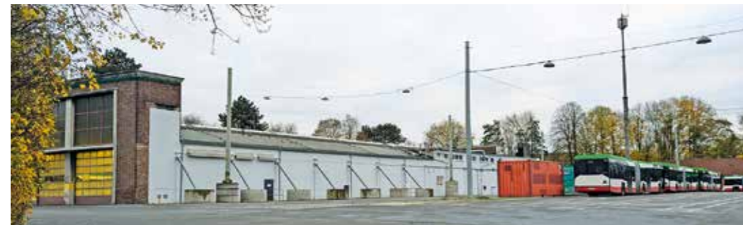
Die Tage des Busstandortes mit integrierter Werkstatt der BOGESTRA in Witten sind gezählt. 200 Mitarbeiter wechseln an andere Standorte.
