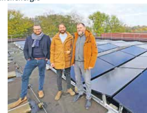
Freuen sich über die Sonnenenergie für das Trinkwasser: (v.l.) Patrick Berg (Stadtwerke Witten), Martin van Well (AVU) und Derk Buchsteiner (VWW). Foto: Stadtwerke Witten
