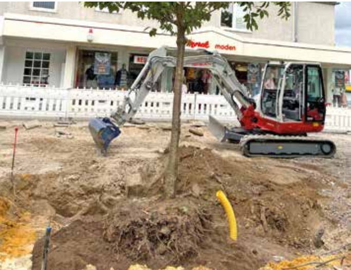
Um den Baum in Welper umpflanzen zu können, musste der Wurzelballen fachgerecht freigelegt werden. Fotos: Feldhaus & Co. GmbH
