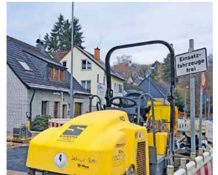
Die Baustelle an der Rauhen Egge. Noch bis mindestens April 2024 werden die Kanalbauarbeiten anhalten. Für rund 900 Buchholzer aus dem Siedlungsgebiet Rauhe Egge bedeutet das weite Umwege, um ins Hammertal zu gelangen. Die Strecke führt über den Waldweg und die Obere Rauhe Egge. Ein großes Problem stellt sich für die Rettungskräfte, die vor der Baustelle oft wieder umdrehen - trotz des Schildes „Einsatzfahrzeuge frei“. Foto: Pielorz
