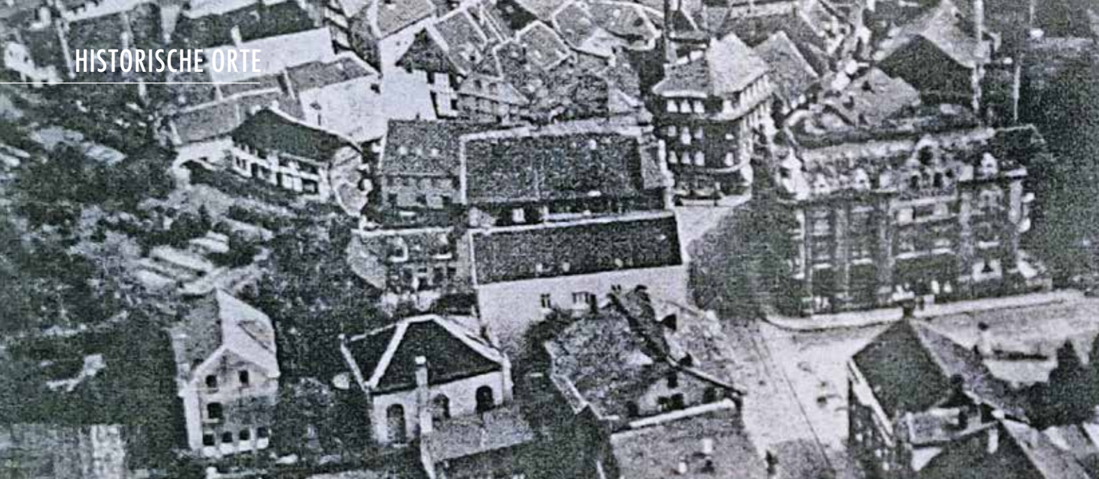
Das jüdische Gemeindezentrum 1937. Im Bild vorne mittig mit dem Walmdach die Synagoge. Heute verläuft dort die August-Bebel-Straße.
