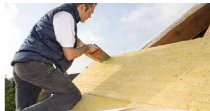
Eine Dachdämmung erfordert immer das Know-how eines Fachbetriebs.
