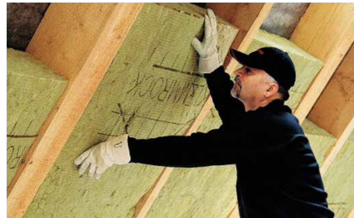
Eine Zwischensparrendämmung ist gefragt, wenn ein Dachausbau, aber keine umfassende Dachsanierung ansteht. Eine Dämmung zwischen den Sparren ist wirtschaftlich und so unkompliziert, dass sie in Eigenregie realisierbar ist.
