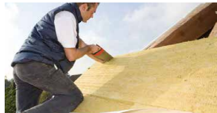
Eine Dachdämmung erfordert immer das Know-how eines Fachbetriebs. Foto: Knauf Insulation GmbH
