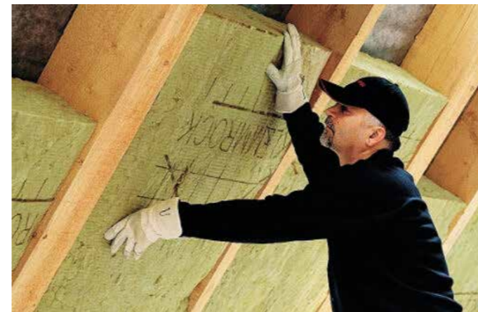
Eine Zwischensparrendämmung ist gefragt, wenn ein Dachausbau, aber keine umfassende Dachsanierung ansteht. Eine Dämmung zwischen den Sparren ist wirtschaftlich und so unkompliziert, dass sie in Eigenregie realisierbar ist. Foto: DEUTSCHE ROCKWOOL GmbH & Co. KG
