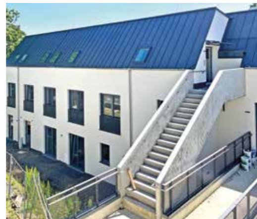
Der Gebäudekomplex im Quartier Isenhöhe. Im Untergeschoss ist mittlerweile die KiTa an den Start gegangen. Im Obergeschoss ziehen aktuell die Demenz-WG ein. Foto: hwg eG
