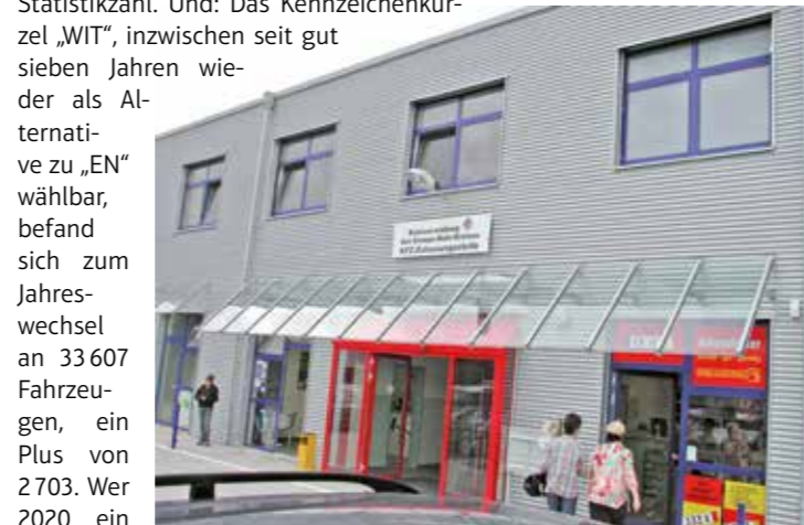
Bürger des Kreises haben in Schwelm und in Witten – im Bild die Nebenstelle – die Möglichkeit, Fahrzeuge an-, um- und abzumelden. Foto: Uvk
