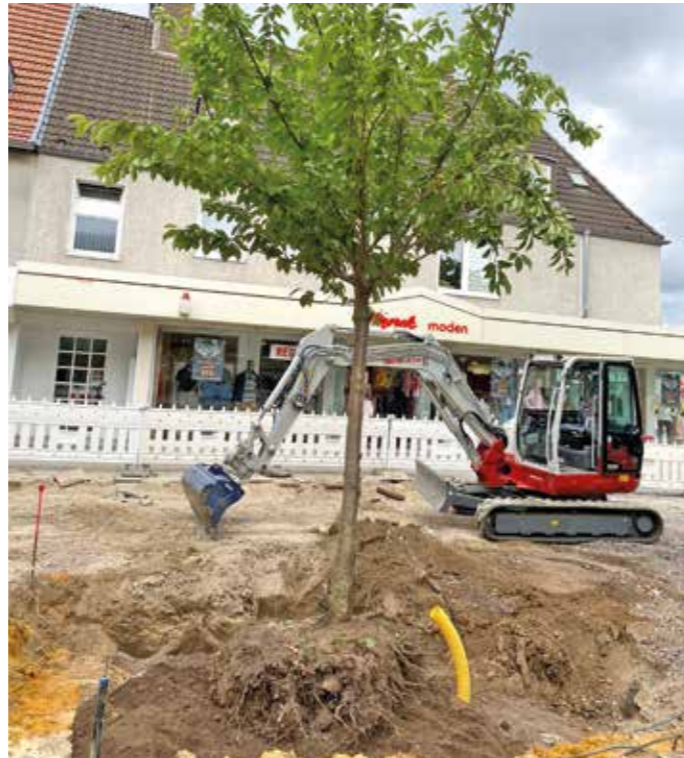
Um den Baum in Welper umpflanzen zu können, musste der Wurzelballen fachgerecht freigelegt werden. Foto: Feldhaus & Co. GmbH
