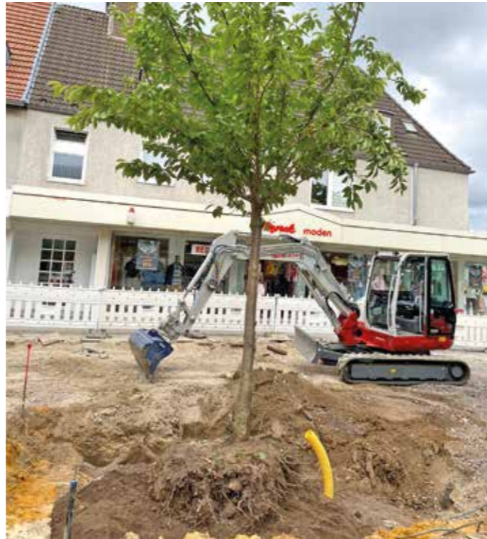
Um den Baum in Welper umpflanzen zu können, musste der Wurzelballen fachgerecht freigelegt werden. Foto: Feldhaus & Co. GmbH
