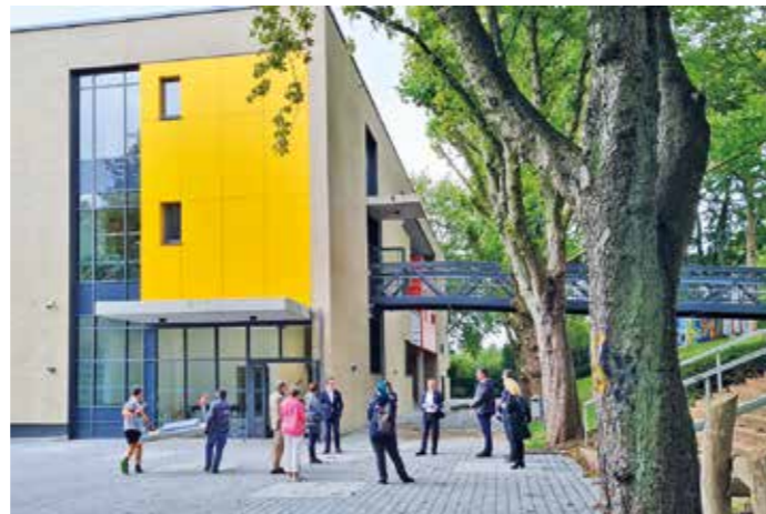
Letzte Möbel wurden noch hineingeschafft, als der Erweiterungsbau der Gesamtschule Hattingen-Welper seiner Bestimmung übergeben wurde.
