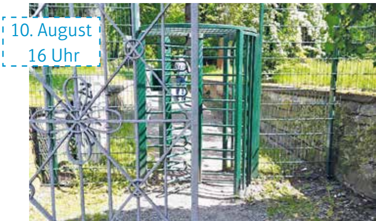
Ein Drehkreuz ist ein Hindernis für Gehbehinderte und Rollstuhlfahrer.
