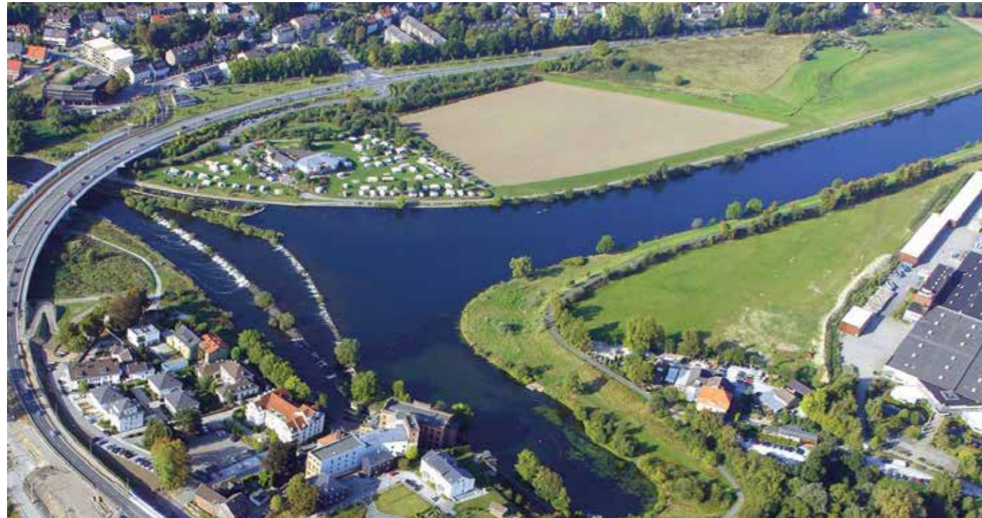
Um die heute landwirtschaftlich genutzte Fläche neben dem Campingplatz Stolle geht es - hier soll die Ruhrpromenade entstehen.
