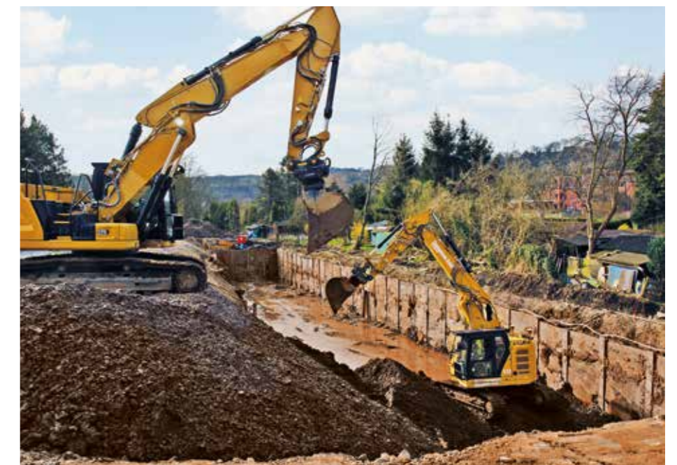
Zurzeit wird eine Baugrube ausgehoben, in die ein Regenrückhaltebecken gebaut wird.
