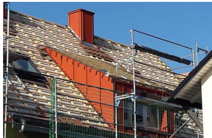
Ist der Dachboden bereits ausgebaut, ist die Aufsparrendämmung die beste Lösung für die Dachdämmung. Foto: energie-fachberater.de
