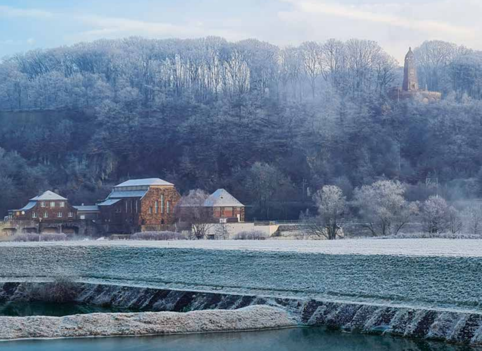
Blick auf das Wasserkraftwerk Hohenstein und Bergdenkmal Foto: Petra Ortwein
