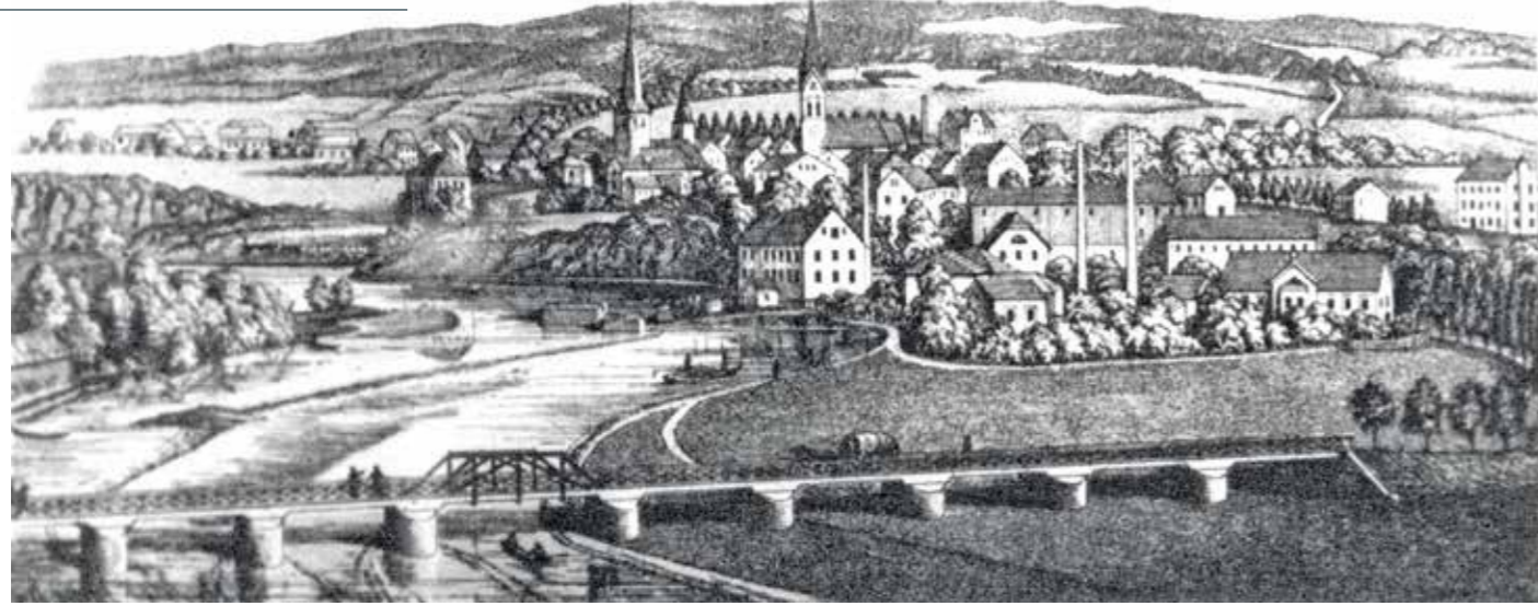
Die Hattinger Ruhrbrücke 1885.
