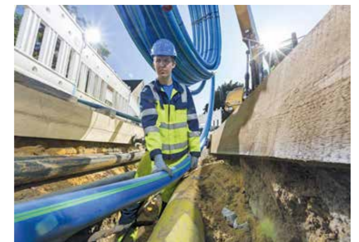
Gelsenwasser-Mitarbeiter beim hauseigenen Rohrzugsverfahren.
