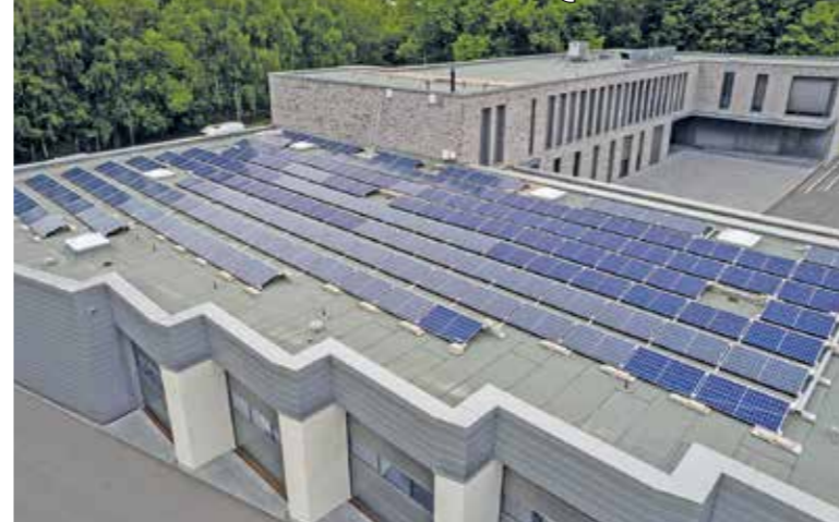
Die Solaranlage auf dem Dach der Zentrale der Stadtwerke Hattingen umfasst 170 Solarmodule. Foto: Mike König Photography
