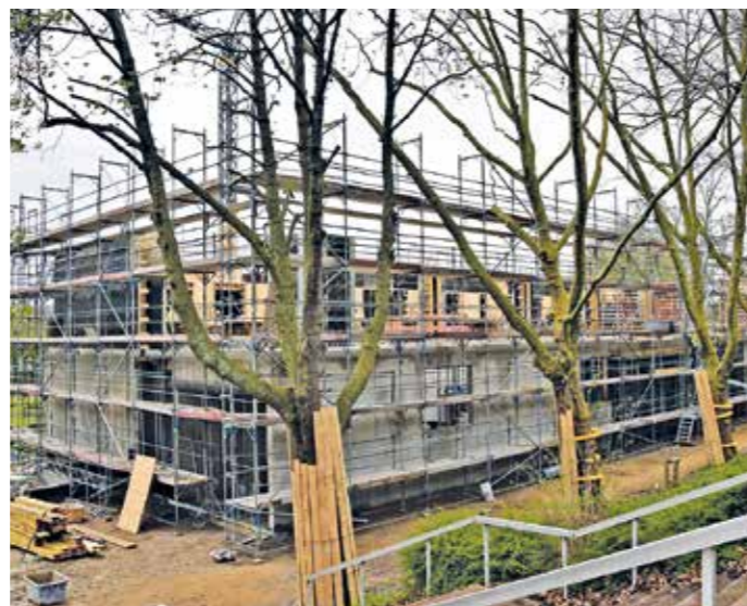
Erweiterungsbau der Gesamtschule in Welper
