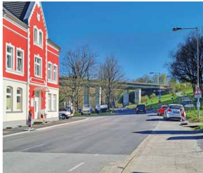
Die neue Fahrbahndecke hat die Straße „Im Hammertal“ erreicht. Nun möchte die SPD wissen, ob auch ein Radweg gebaut werden kann.
