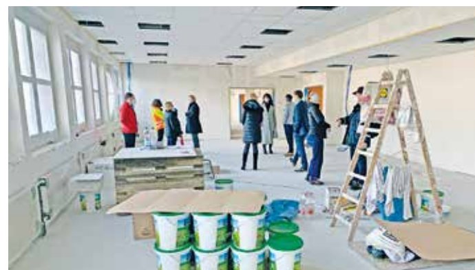
Begehung Klassenzimmer E. Politiker und Mitarbeiter aus dem Kreis und der Stadt Sprockhövel, darunter Bürgermeisterin Sabine Noll, haben sich vor Ort ein Bild gemacht: In den Klassenzimmern des Gebäudeteils E können nun die Malerarbeiten starten.
