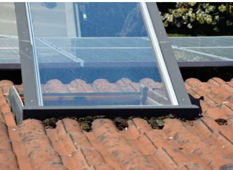
Anschlüsse an Dachdurchdringungen bei Dachfenstern werden beim Dach-Check begutachtet. Foto: HF Redaktion/akz-o
