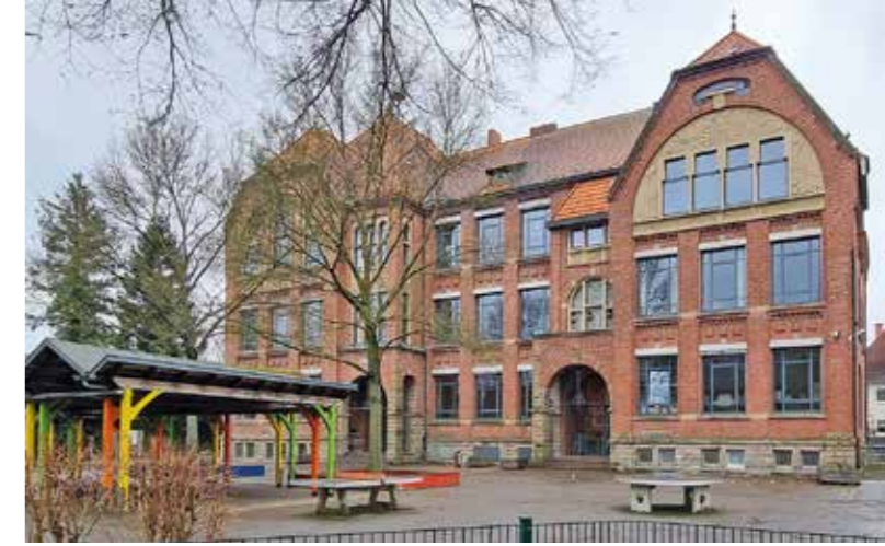
Nur noch bis 31. Juli 2027 wird der Unterricht an der Hamburgstraße stattfinden. Foto: Tanja Schneider
