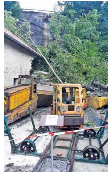
Schwere Schäden auf dem Grubenbahngelände löste das Julihochwasser vom 14. auf den 15. Juli durch einen Hangrutsch aus. Fotos: Arge Muttenthalbahn
