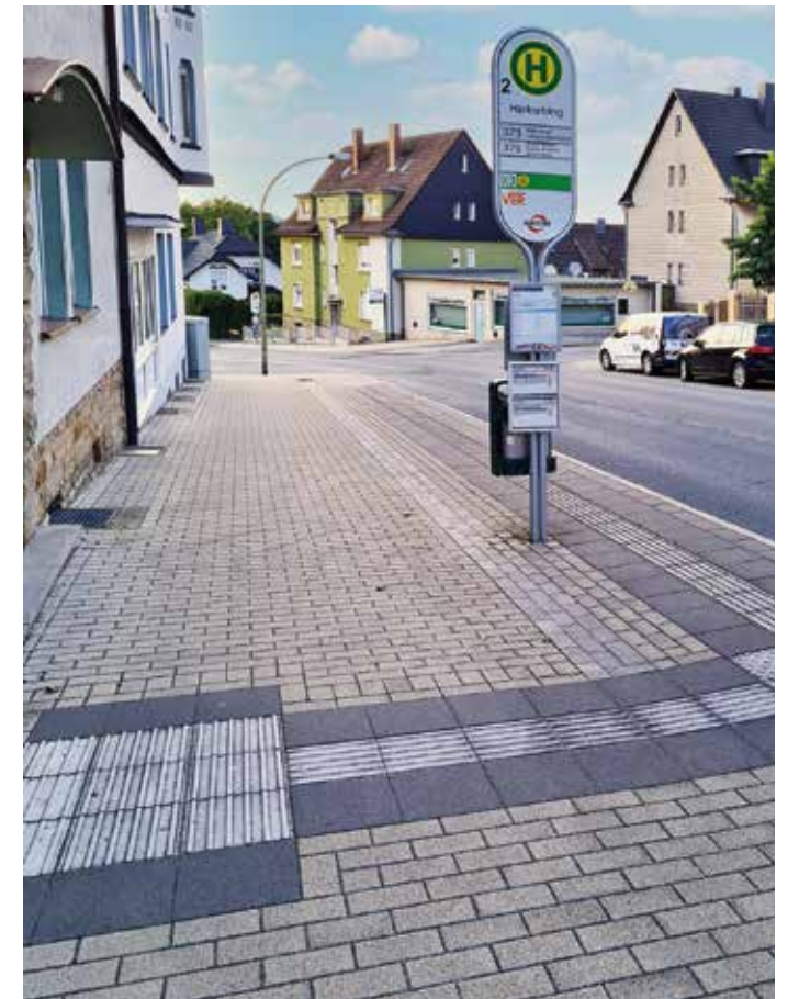
Auch an der Holzkampstraße in Witten-Annen erhöht an der Bushaltestelle „Harkoring“ ein Bodenleitsystem die Sicherheit für blinde Mitbürger.
