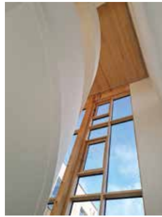
Im Treppenhaus des neuen Uni-Gebäudes zeigt sich die Hybridbauweise mit Beton und Holz. Foto: dx
