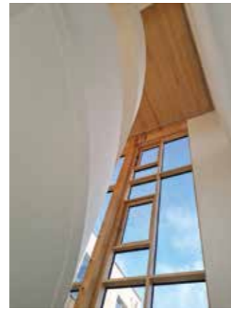
Im Treppenhaus des neuen Uni-Gebäudes zeigt sich die Hybridbauweise mit Beton und Holz. Foto: dx
