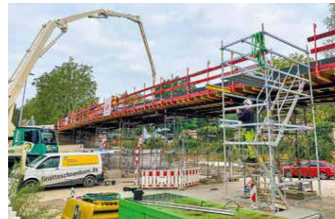
Betonpumpe im Einsatz an der zukünftigen Brücke des Rheinischen Esels.
