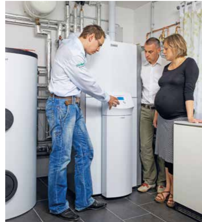
Wenn es draußen richtig warm ist, können viele Wärmepumpen dazu genutzt werden, um die Wohnräume energieeffizient zu kühlen. Foto: txn/Bundesverband Wärmepumpe e.V.
