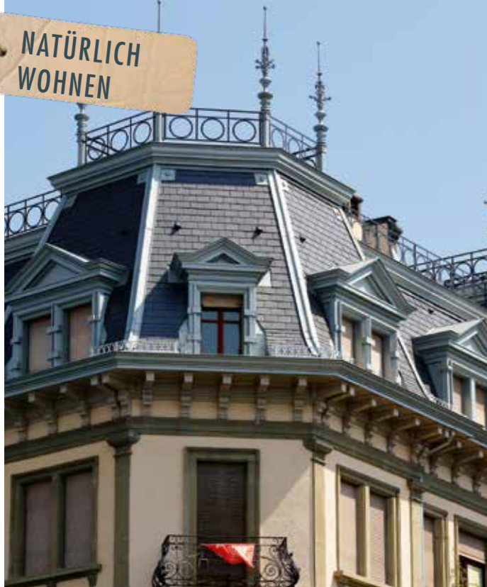
Zink ist ein ökologischer Baustoff, der sich in nahezu jede beliebige Form bringen lässt – und dann Gebäude dauerhaft vor Wind und Wetter schützt. Kein Wunder, dass der traditionelle Baustoff auch heute noch stark gefragt ist. Foto: Cornelia Suhan
