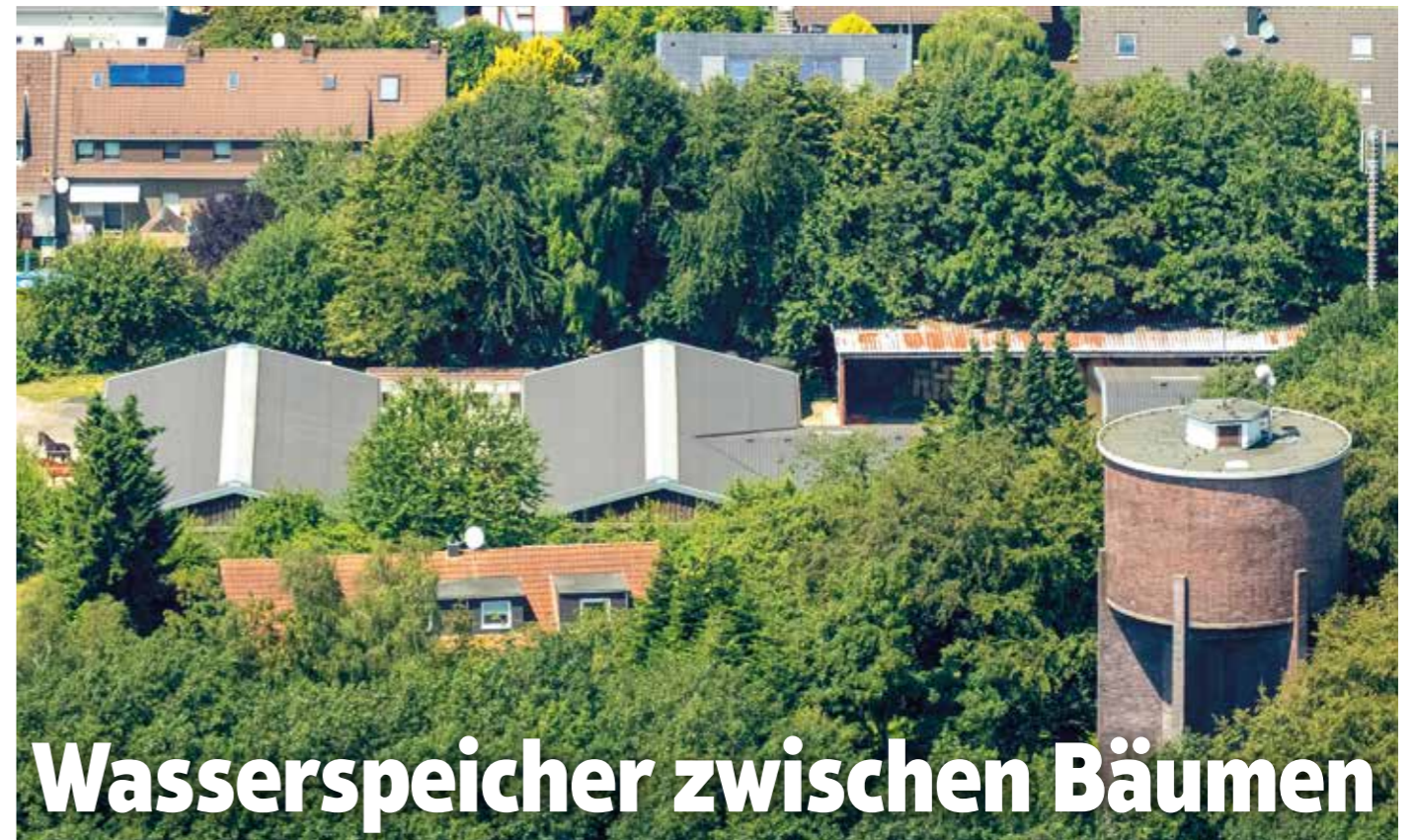
Das Verbundwasserwerk Essen-Horst/Überruhr versorgt den Hochbehälter mit Nachschub. Am Balkhauser Weg wird das kostbare Nass in den Turm gepumpt. „euroluftbild.de/Hans Blossley“
