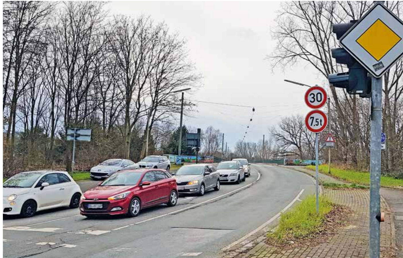
Die Ruhrbrücke nach Herbeder soll 2024 abgerissen und neu gebaut werden. Um über die Zeit zu kommen, ist die Fahrbahn für Lkw und Busse gesperrt. Jetzt sind die Fahrbahnschäden so groß geworden, dass der Verkehr die Ruhrbrücke nur mit maximal Tempo 30 überqueren darf. Erst bei höheren Temperaturen können die Schäden mit Asphalt ausgebessert werden.
