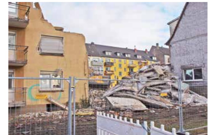
In Bahnhofsnähe kreist die Abrissbirne und arbeitet der Bagger. Deswegen und wegen der folgenden Bauarbeiten dauert die Sperrung noch das ganze Jahr.
