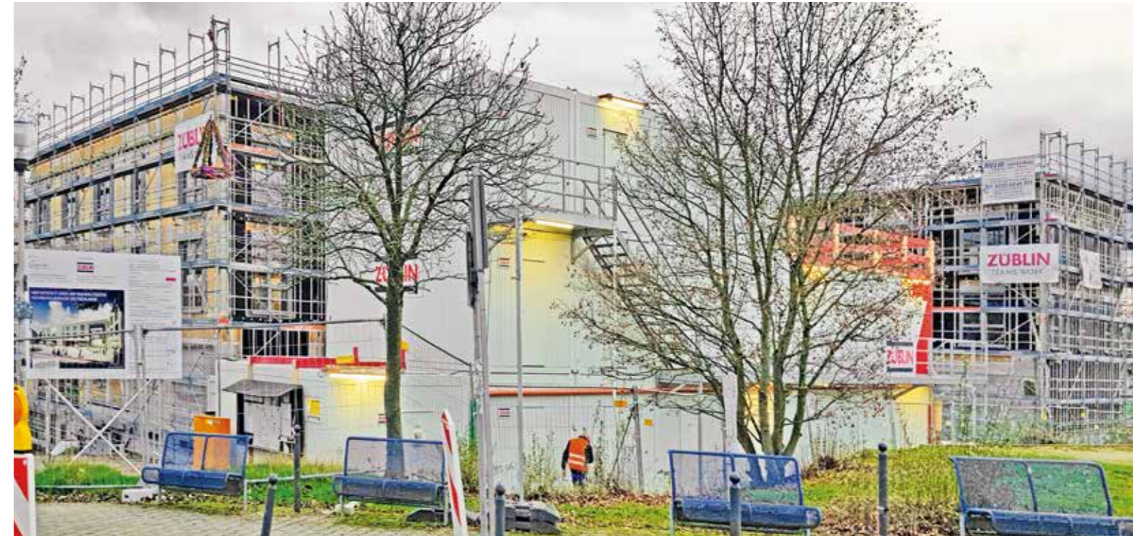
Einer der nachhaltigsten Hochschulbauten Deutschlands entsteht überwiegend in Holzbauweise auf dem Campus der Privatuniversität Witten/Herdecke zwischen dem bestehenden Gebäude und dem Forschungs- und Entwicklungszentrum, von der Stadt aus gesehen auf der rechten Seite der Zufahrtsstraße. Das neue Gebäude hat eine Grundfläche von 6000 Quadratmetern und umfasst 9 Seminar- und 26 Gruppenräume sowie einen flexibel nutzbaren Veranstaltungsraum für bis zu 350 Personen.
