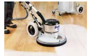
Damit ein sanierter Holzfußboden wie neu aussieht, kommt es auf die richtigen Schleifmaschinen an. Die von Bona empfohlenen Handwerker nutzen Geräte mit einer speziellen Staubabsaugung. Foto: Bona/txn
