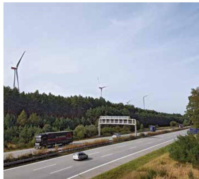
Der Standort des Windparks im brandenburgischen Spreenhagen besteht größtenteils aus Wirtschaftswald unweit des namensgebenden Autobahndreiecks Spreeau. Grundstückseigentümerin des Areals ist die Bundesanstalt für Immobilienaufgaben (BImA), die sich seit vielen Jahren für die Nutzung erneuerbarer Energien einsetzt. Die Windkraftanlagen sind 244 Meter hoch, haben eine Nabenhöhe von knapp 170 Metern und einen Rotordurchmesser von 150 Metern.
