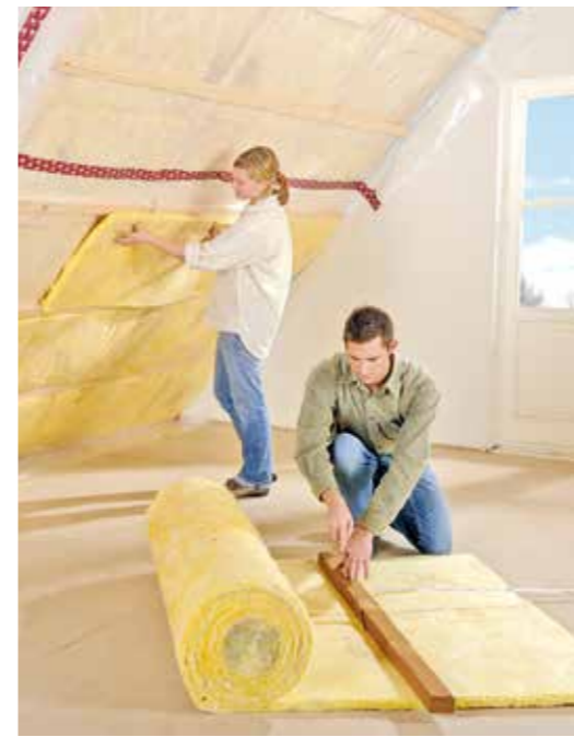
Viele Hausbesitzer machen sich bei der Wärmedämmung ihrer Gebäude auch Gedanken über den baulichen Brandschutz. Hierbei gilt: Nur Baustoffe der Euroklasse A1 sind nicht brennbar. Mineralische Dämmstoffe entsprechen dieser Anforderung. Foto: Ursa/txn
