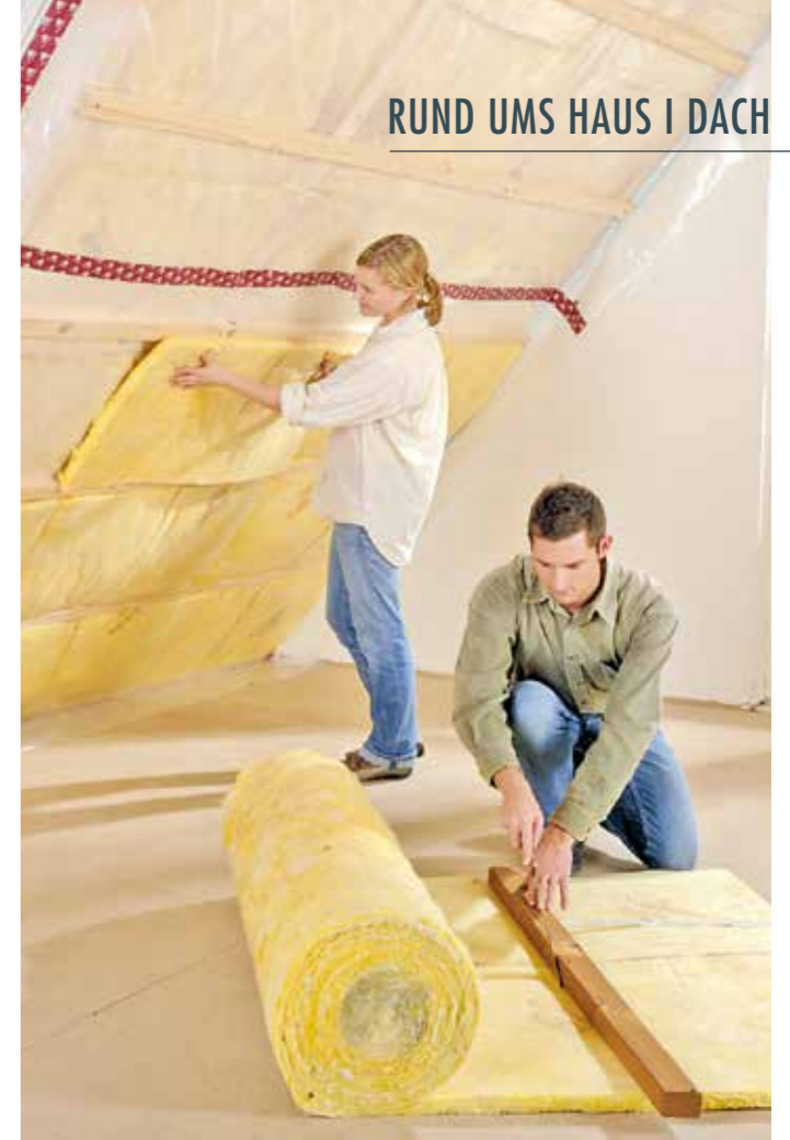
Viele Hausbesitzer machen sich bei der Wärmedämmung ihrer Gebäude auch Gedanken über den baulichen Brandschutz. Hierbei gilt: Nur Baustoffe der Euroklasse A1 sind nicht brennbar. Mineralische Dämmstoffe entsprechen dieser Anforderung. Foto: Ursa/txn
