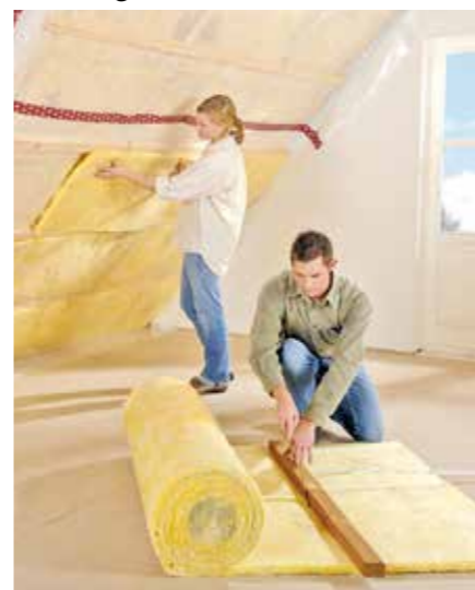
Viele Hausbesitzer machen sich bei der Wärmedämmung ihrer Gebäude auch Gedanken über den baulichen Brandschutz. Hierbei gilt: Nur Baustoffe der Euroklasse A1 sind nicht brennbar. Mineralische Dämmstoffe entsprechen dieser Anforderung. Foto: Urso/txn
