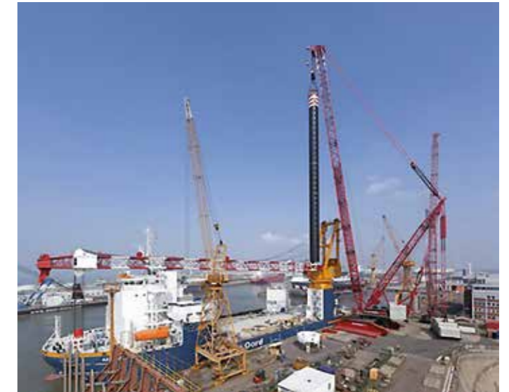
Platz 1: Der erste Rang geht an den Raupenkran „Liebherr LR 13000“ mit einer Gesamthöhe von 245 Metern und einer Traglast von 3 000 Tonnen. Foto: Liebherr-International Deutschland
