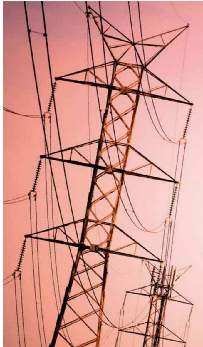
Wie viele Elektronen sich lösen, hängt von den verwendeten Isolationsmedien und der Luftfeuchtigkeit ab. Bei Nebel kommt es zum Beispiel vermehrt zu Entladungen. Auch Staub an den Isolatoren verstärkt das Zischeln. Für den Betreiber sind es zudem Verluste. Materialforscher arbeiten daher an neuen Beschichtungen, die diese Entladungen minimieren.
